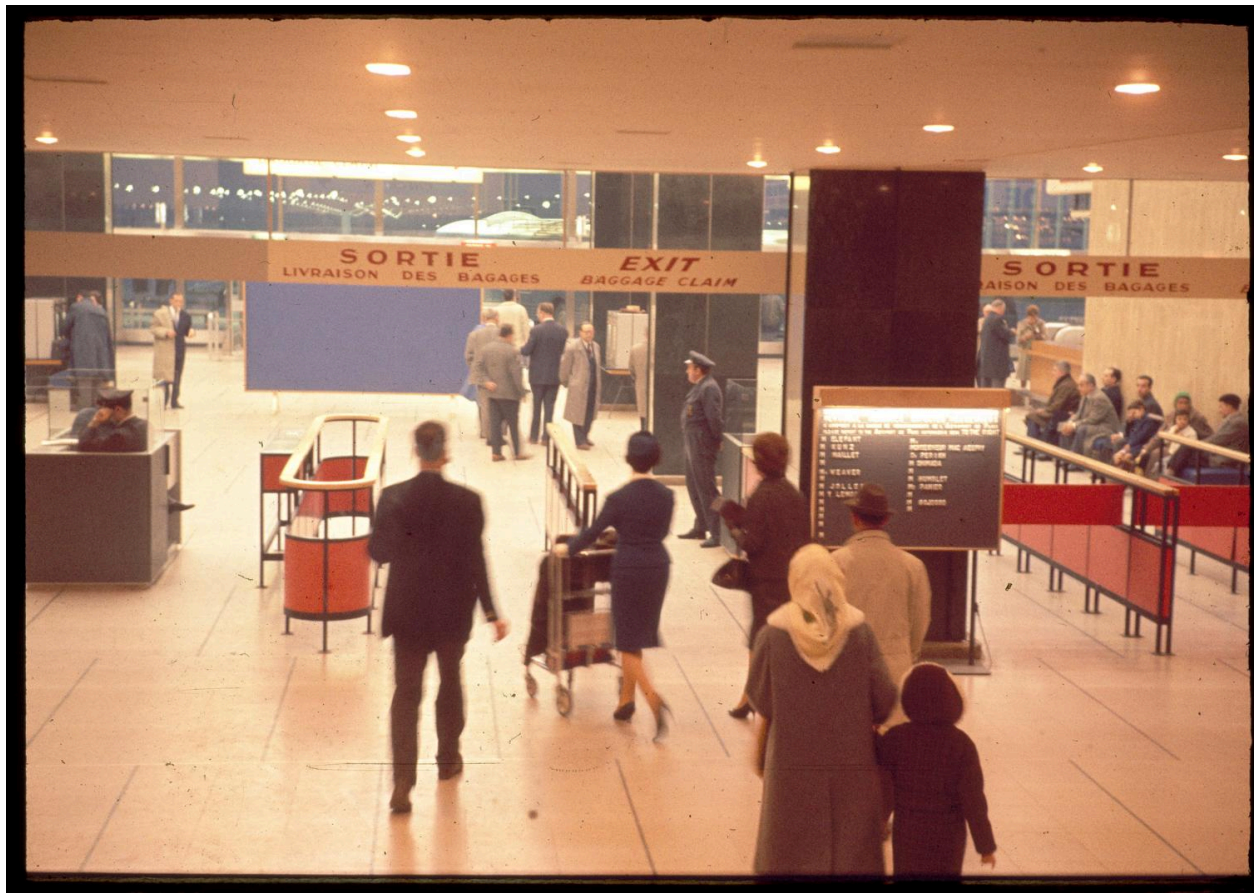
1962, le point de rencontre, rez-de-chaussée.
