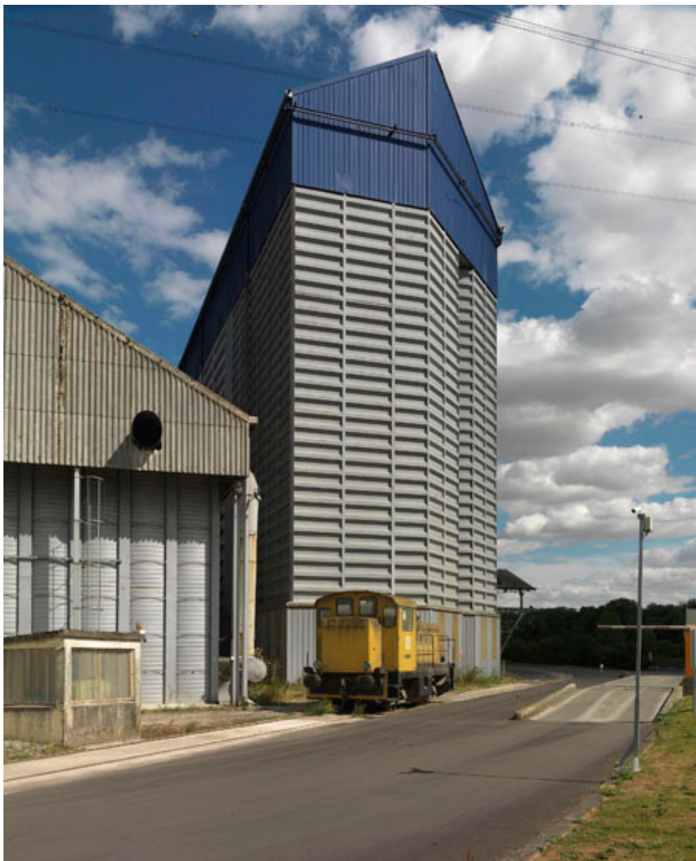
Silos de l'UNCAC Invivo de la Grande Paroisse. Vue extérieure du silo 8. Au pied du bâtiment, une locomotive Decauville.
