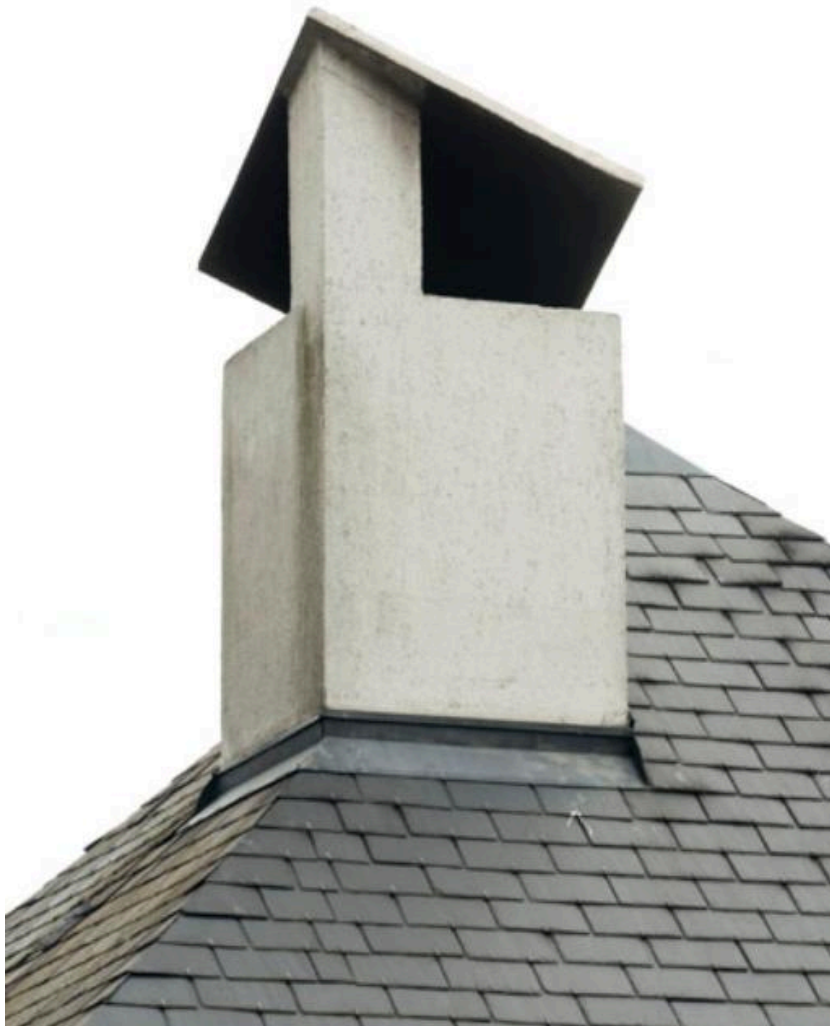
Vue de la façade latérale gauche : détail de la cheminée.
