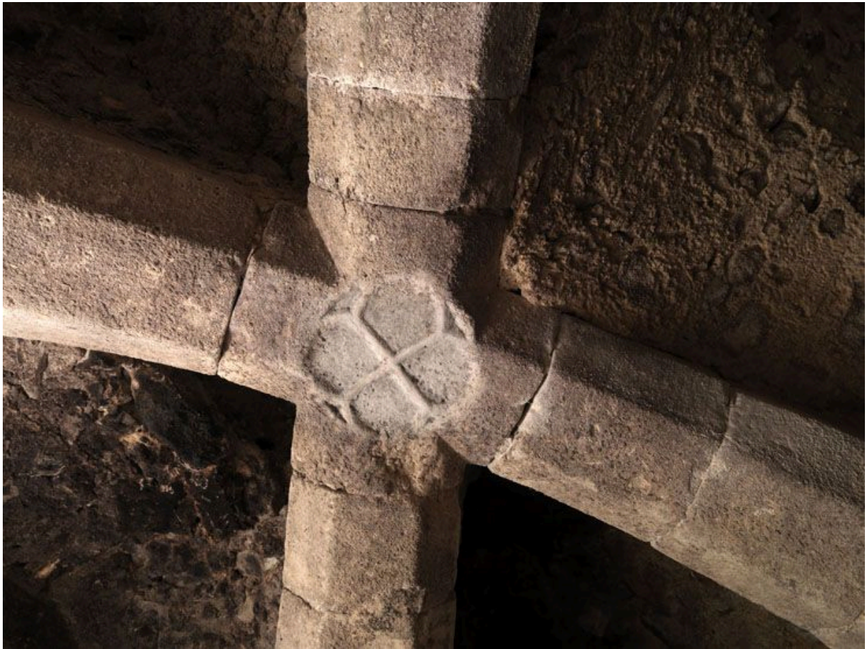
Cave. Clé de voûte de la salle sud-est.
