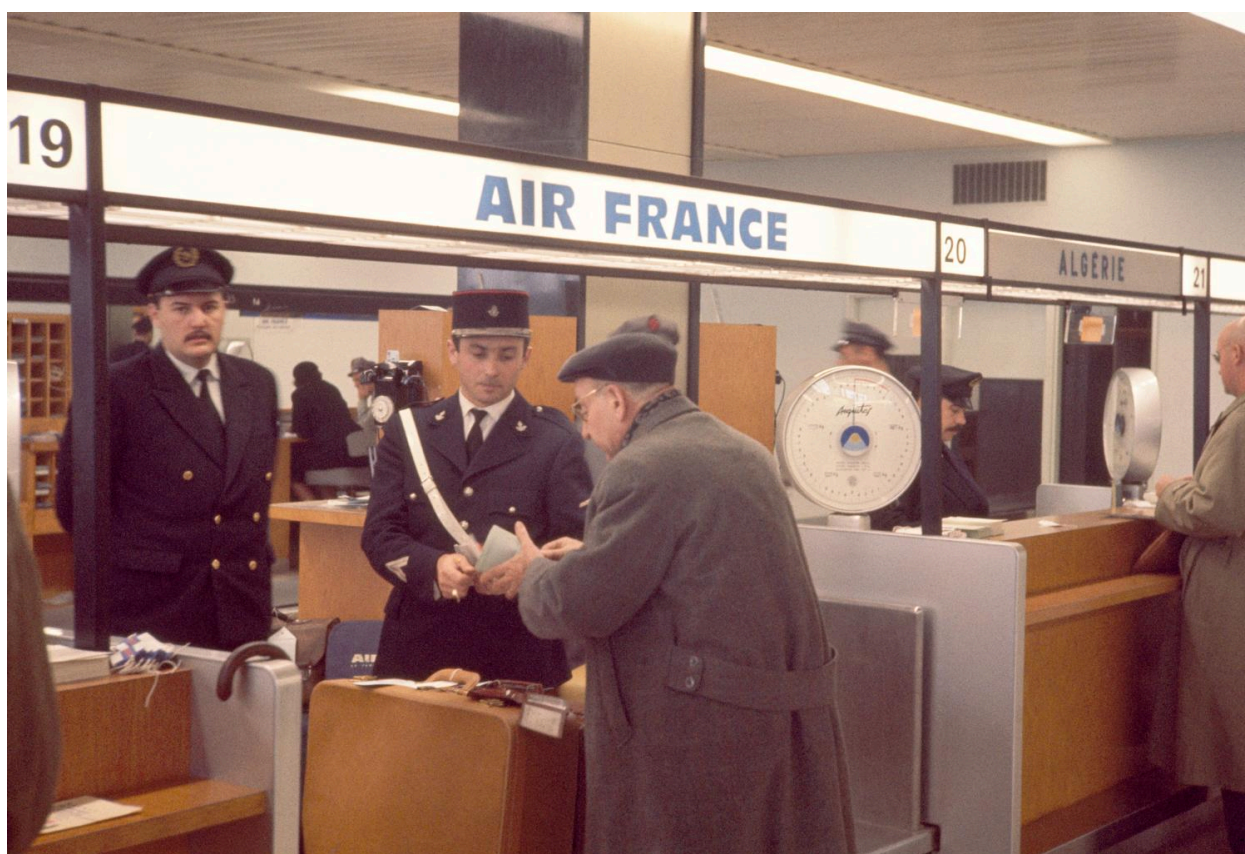
1961, le Grand Hall, comptoir d'enregistrement d'Air France dans la zone départ, rez-de-chaussée.
