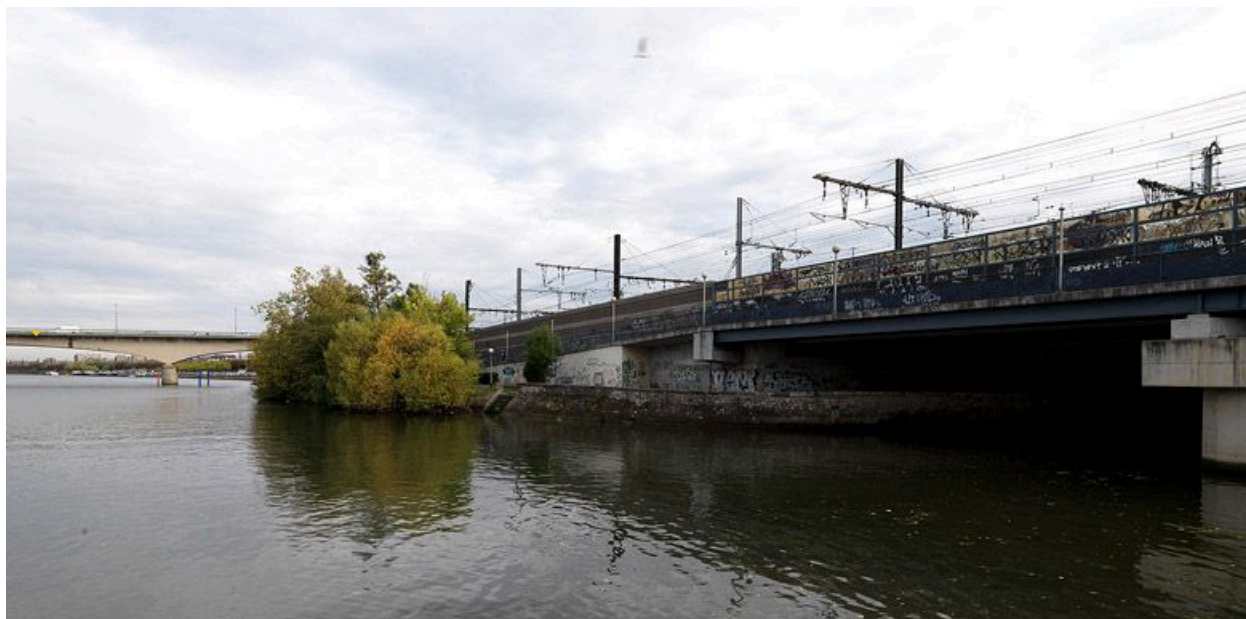
Villeneuve-Saint-Georges . Pont ferroviaire sur l'Yverres. Vue d'ensemble depuis le quai de l'Yverres.
