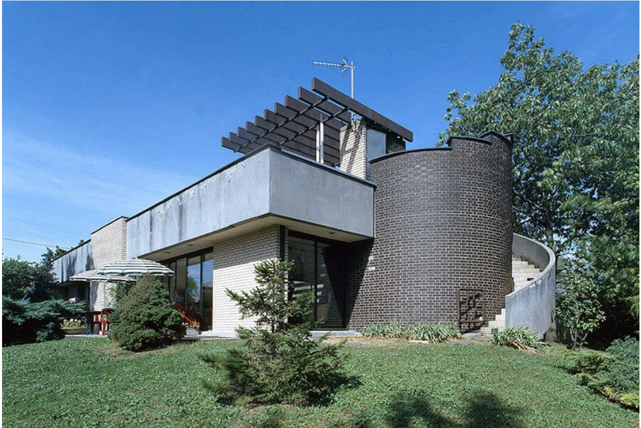
Maison, 158-162 rue de Metz. Vue d'ensemble avec l'escalier extérieur conduisant au toit terrasse au premier plan.
