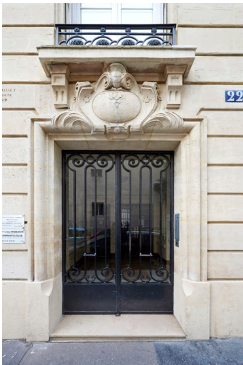
Vue de la porte batarde.
