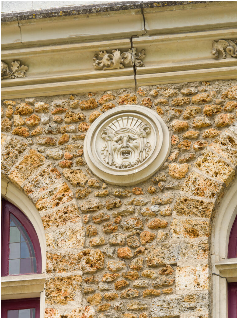
Mascaron sur la façade antérieure et détail de la corniche à chou frisé.
