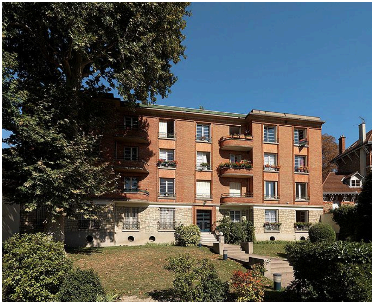
92, Fontenay-aux-Roses, immeuble, 4 avenue René-Isidore. Façade de brique et pierre calcaire côté jardin.
