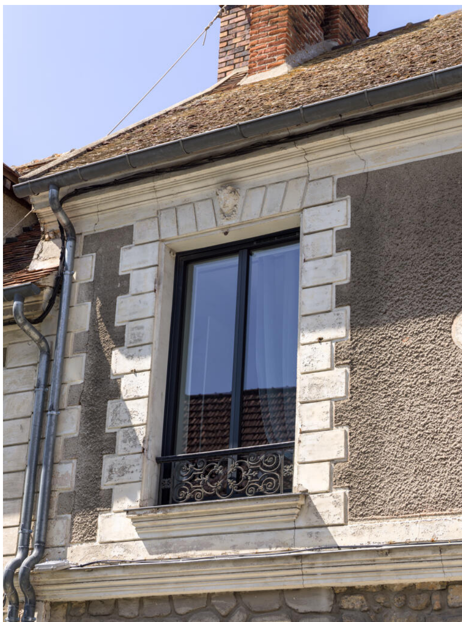
Vue d'une baie de l'étage.
