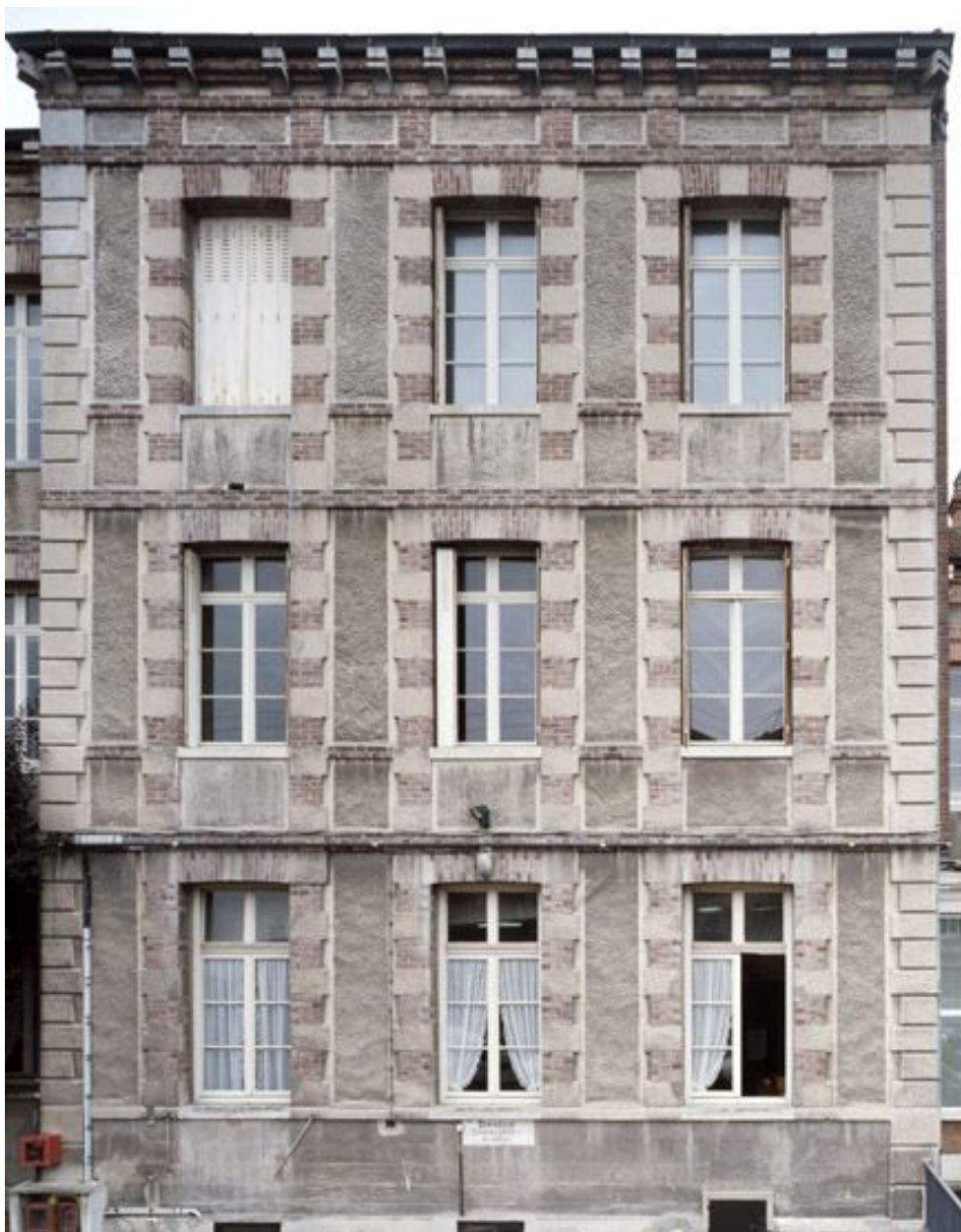
Détail d'une travée de la façade.
