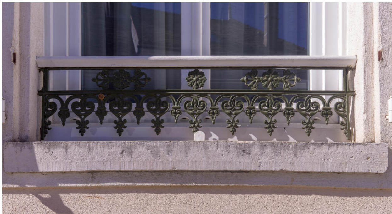
Vue de détail d'un garde-corps.
