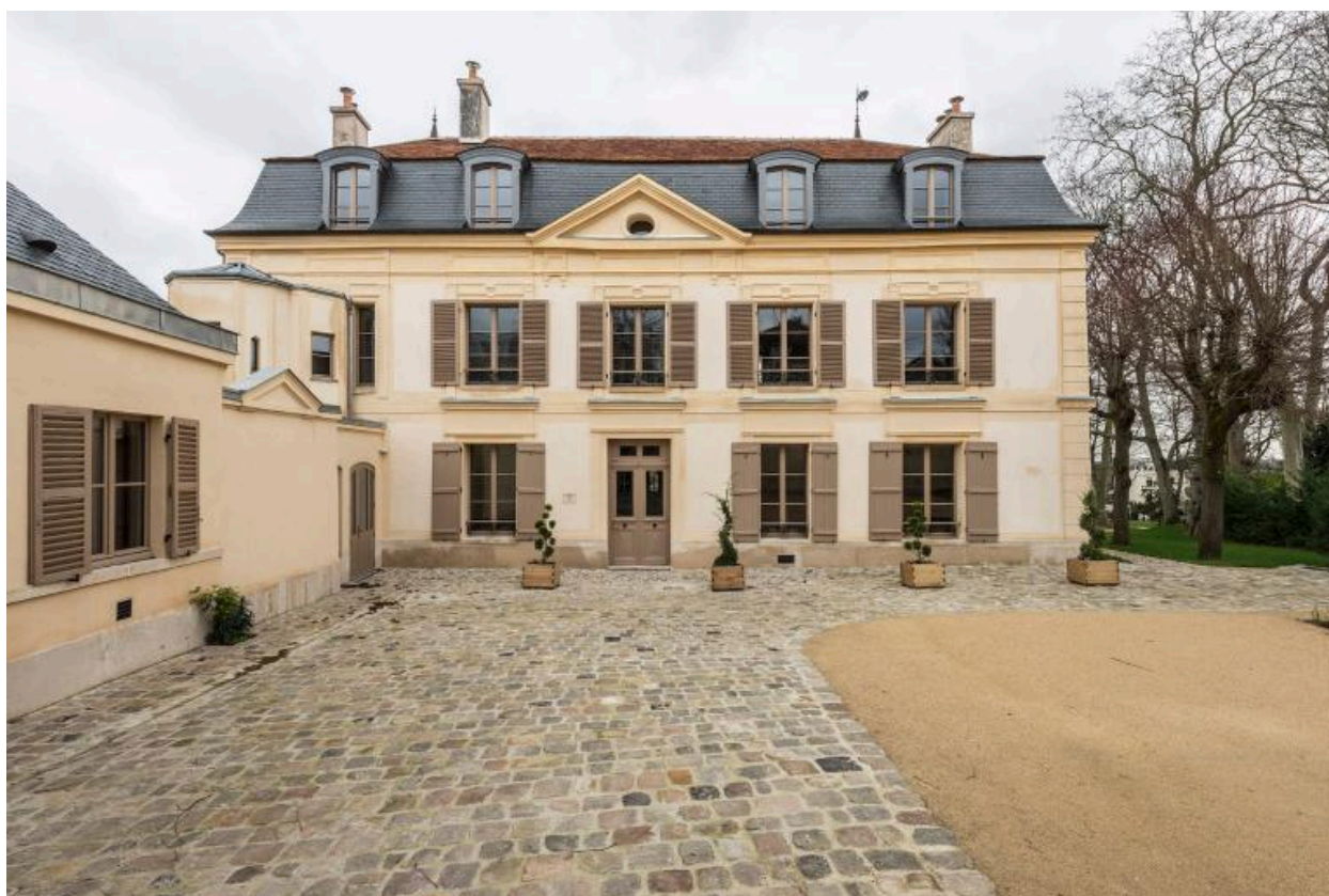
façade sur cour
