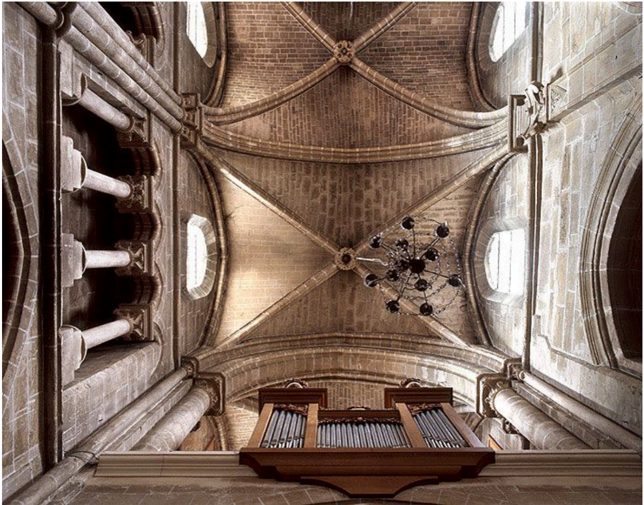
La voûte d'ogives de l'avant dernière travée de la nef.
