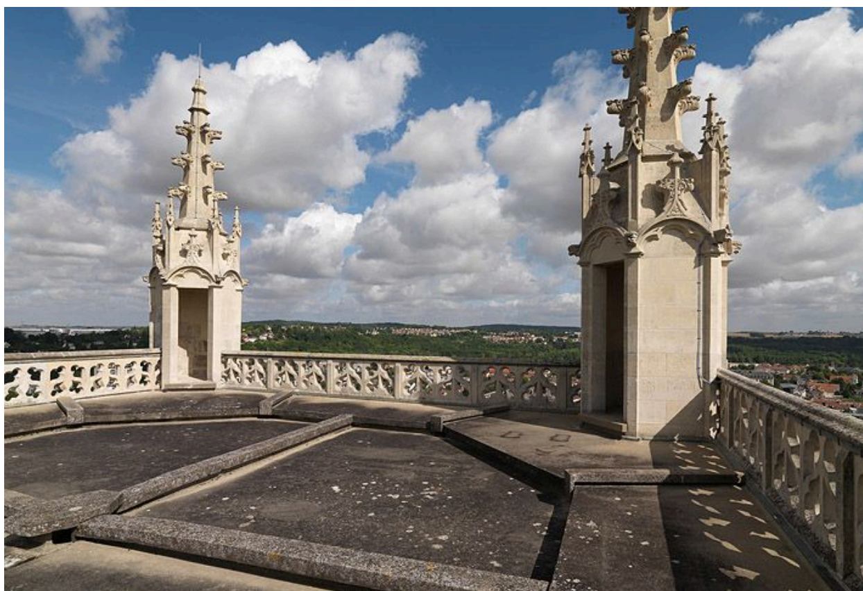
Vue du toit-terrasse au sommet de la tour nord.
