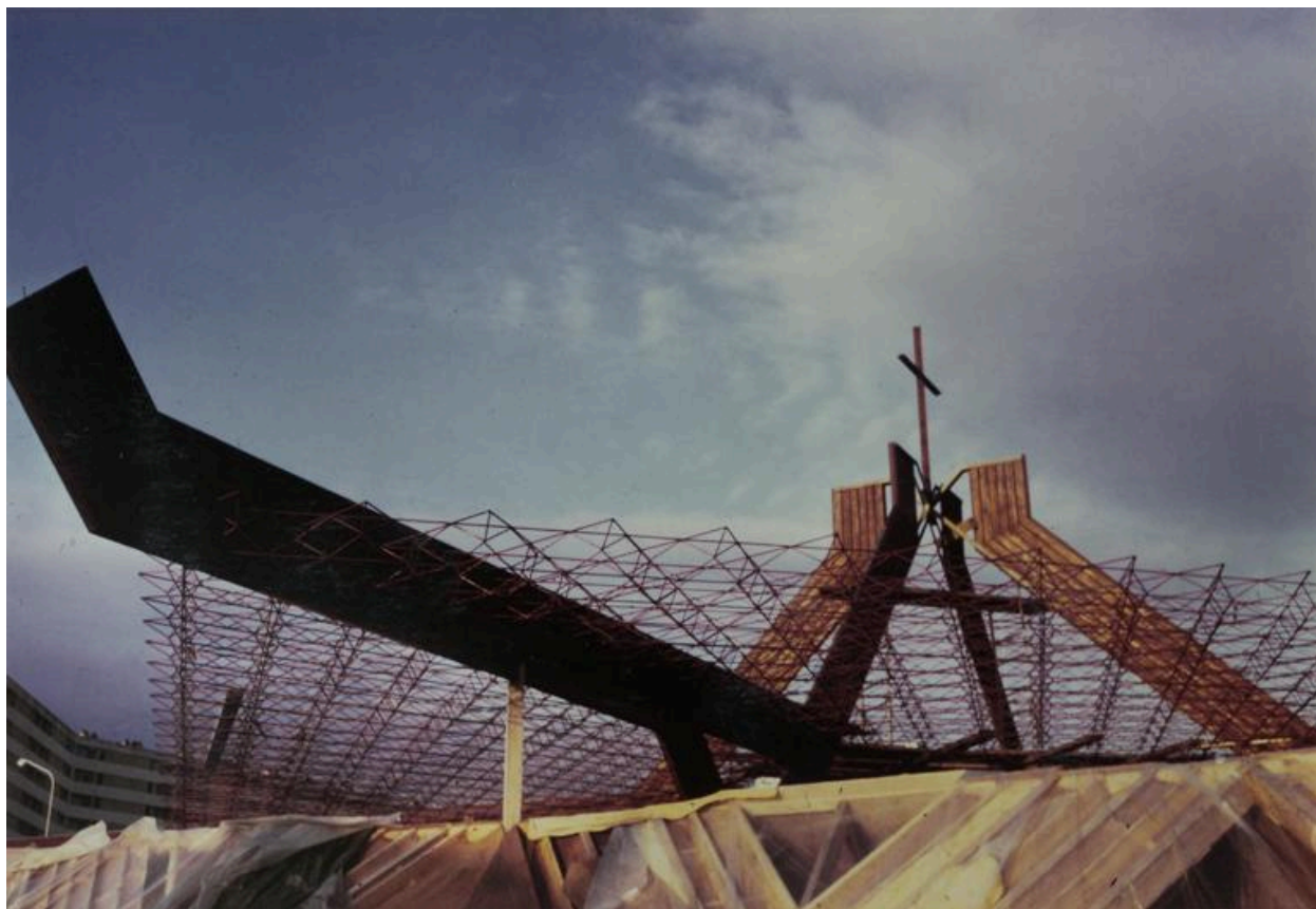
Vue de la charpente en construction.
