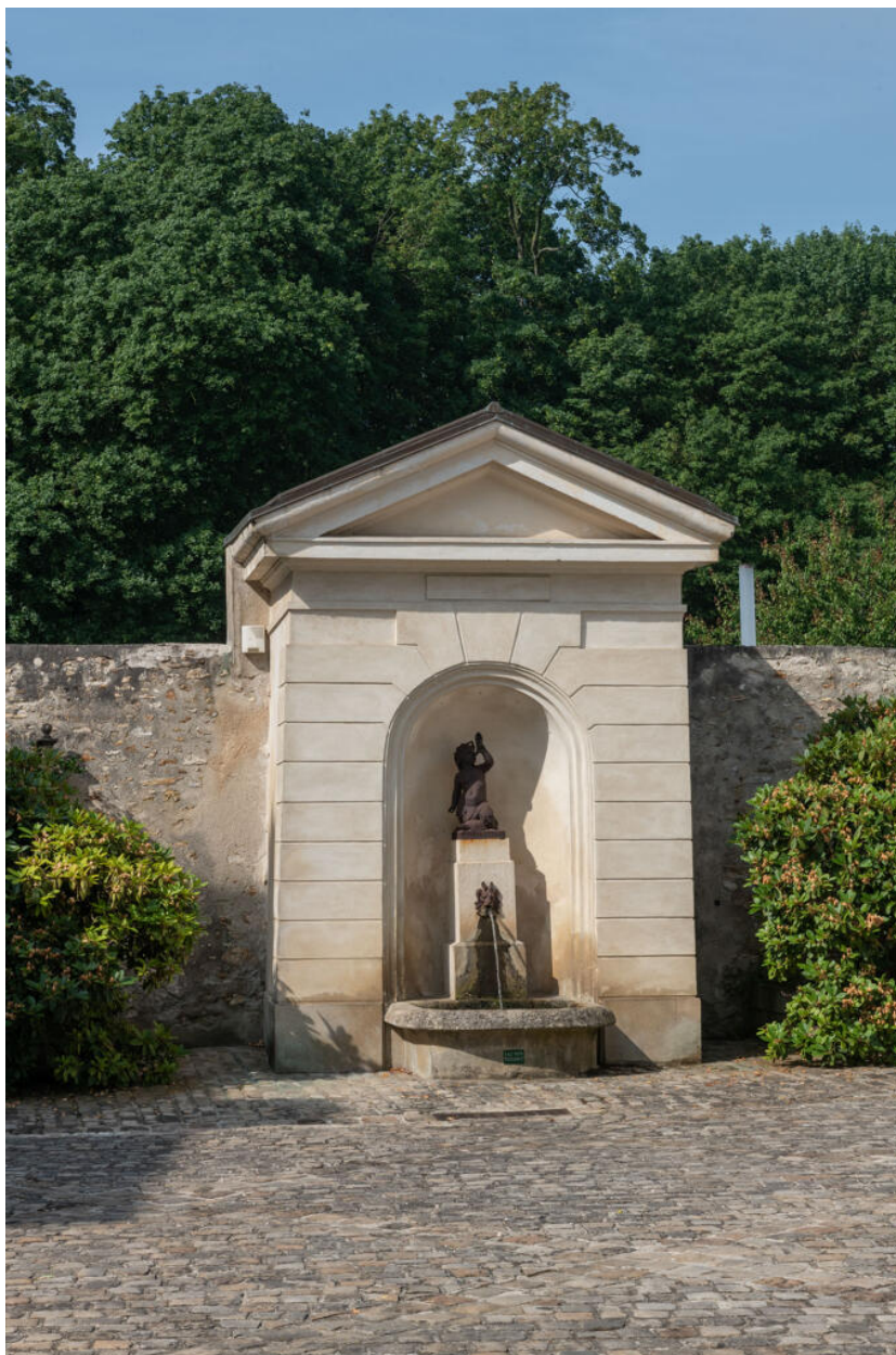
La fontaine, qui jouxte la maison.
