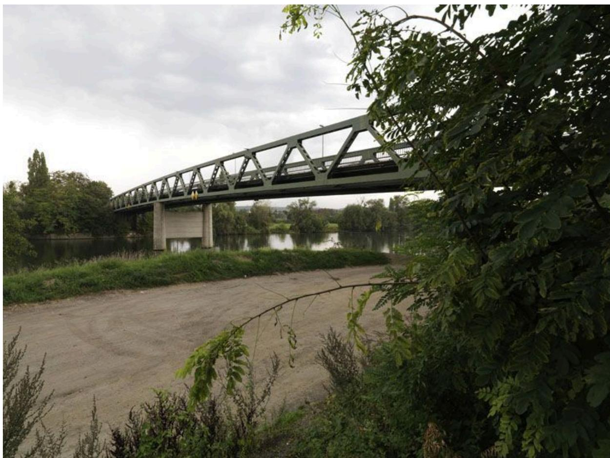
Première travée de l'ouvrage qui s'appuie sur une pile en béton, vue depuis les berges d'Epône.
