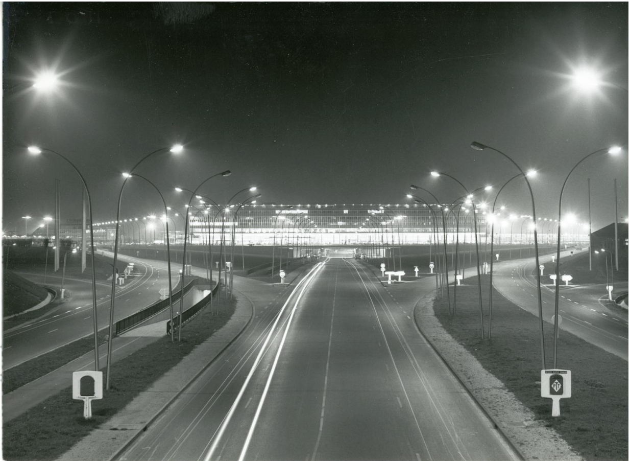
1961, les Installations terminales vues depuis le nord.
