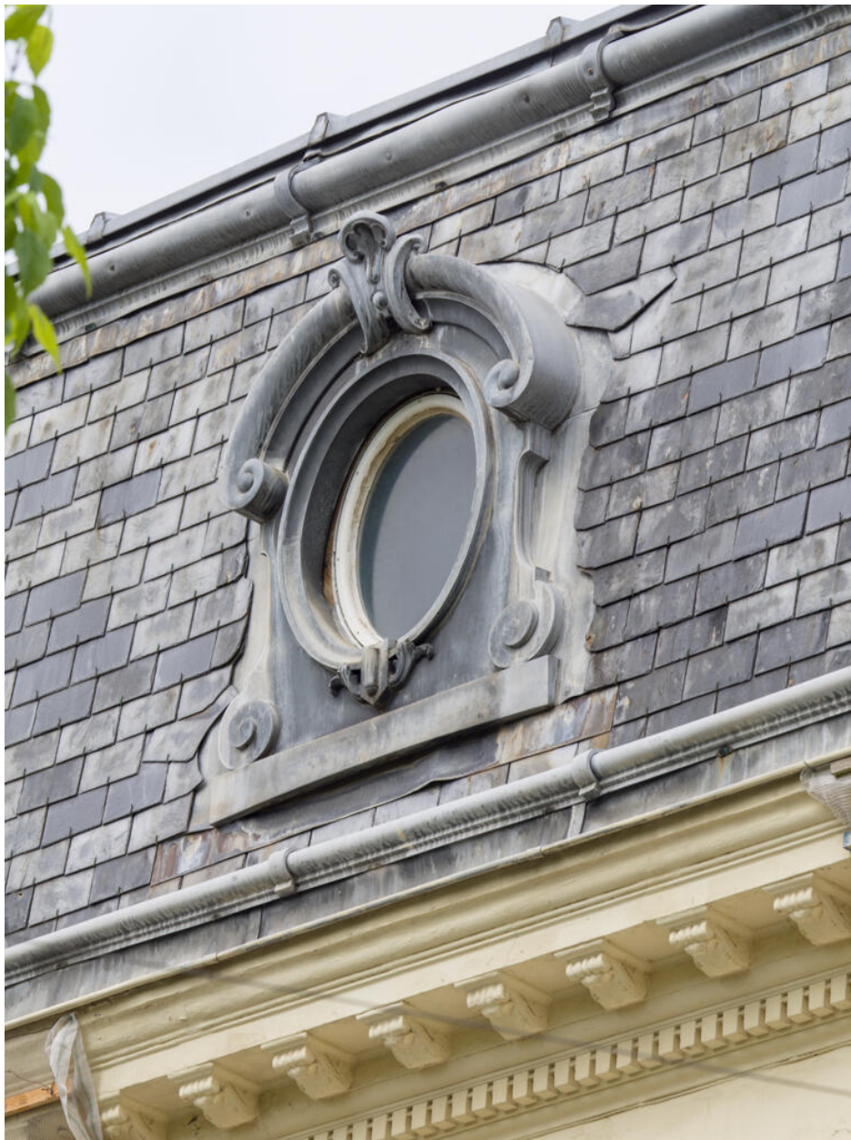
Détail du toit à la Mansart.
