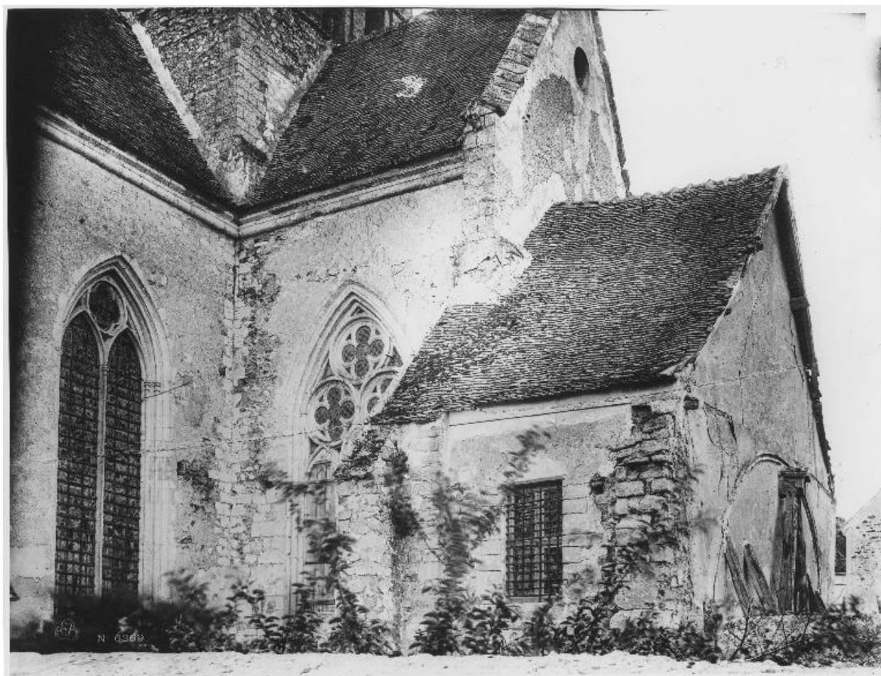
Vue du bas-côté nord avant restauration. (Fonds CREDOP).
