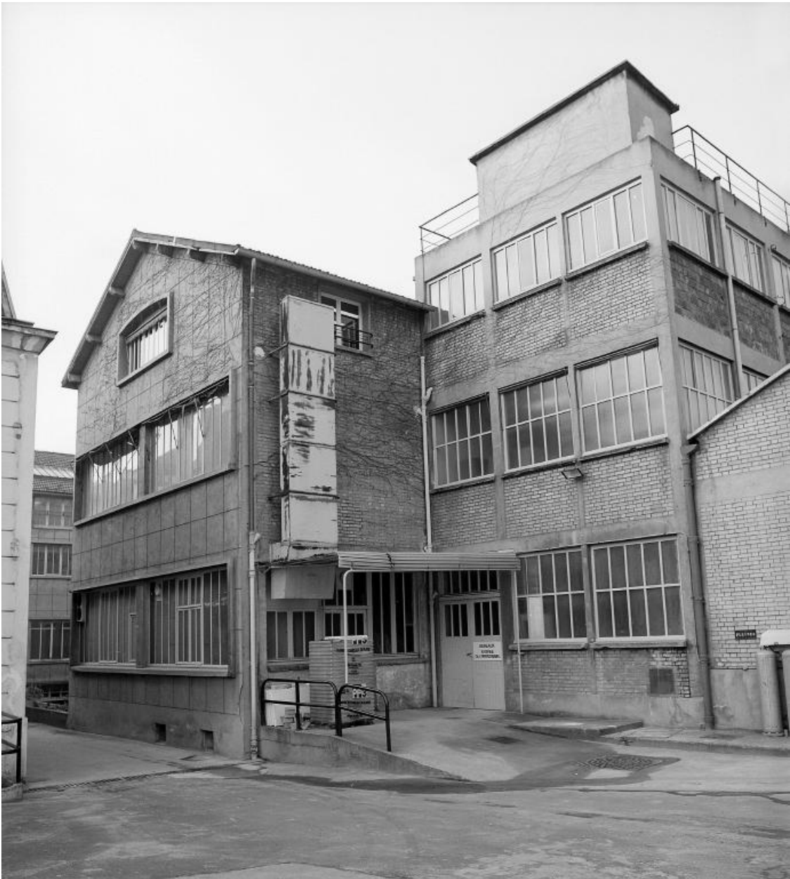
Vue des ateliers et bureaux. Photographie. (AD Seine-Saint-Denis. A NB 118)
