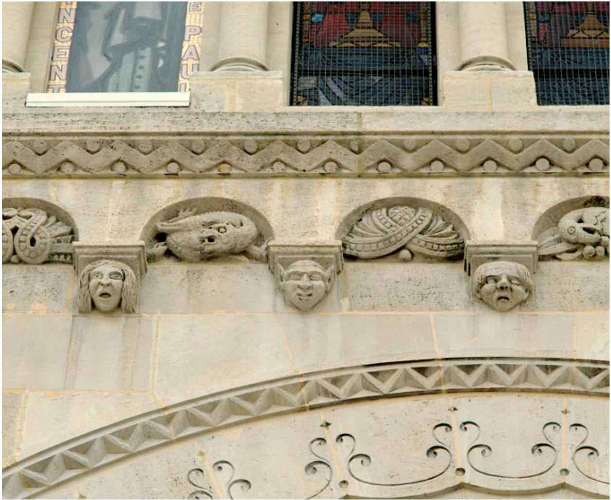
Façade occidentale : détail de la corniche.
