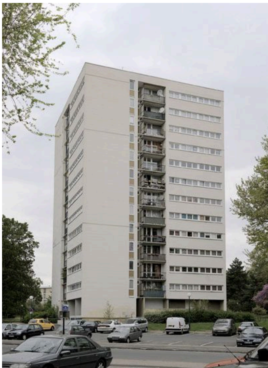
Vue générale de la tour N.
