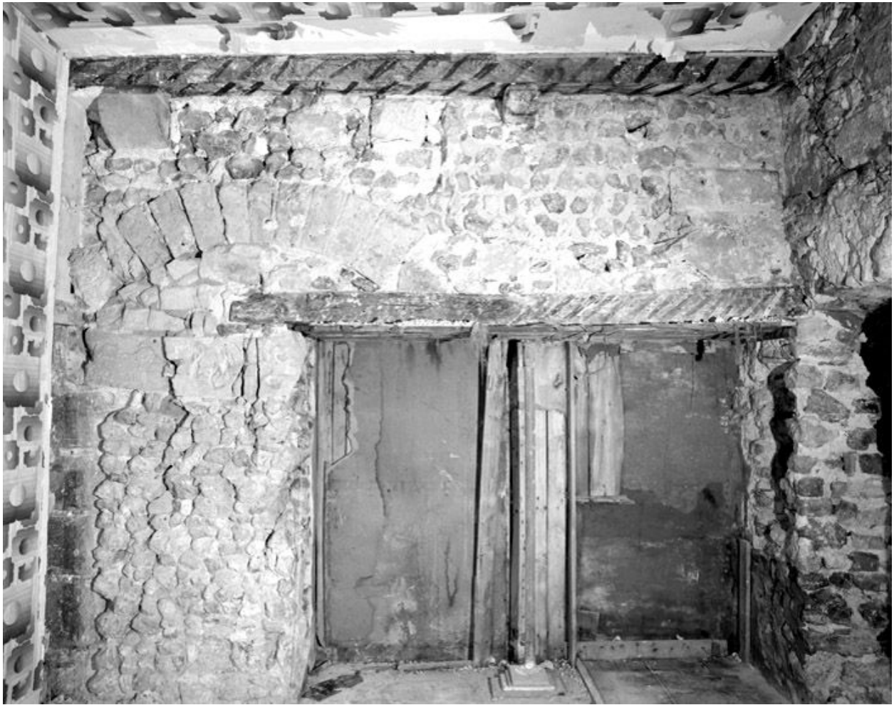
La façade originelle de l'église (11e-12e siècles), en cours de dégagement dans la maison au 5, rue du Château (fouilles F. Henrion, octobre 2003).
