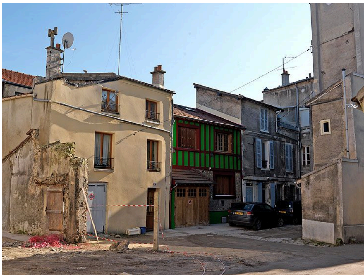
Cour commune au 55, rue du Faubourg Saint-Nicolas.
