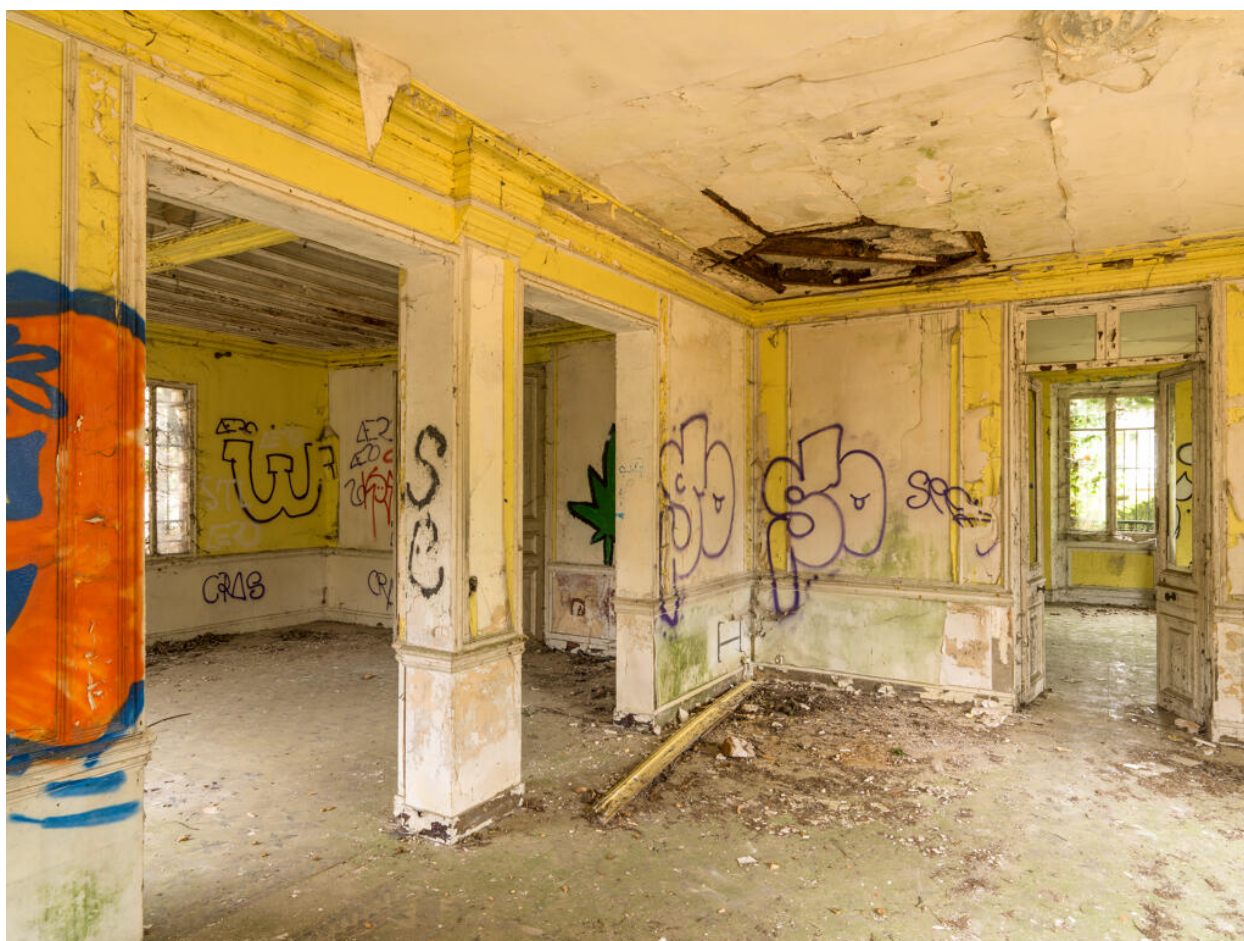
Maison d'Octave Allaire, pièce non-identifiée du rez-de-chaussée
