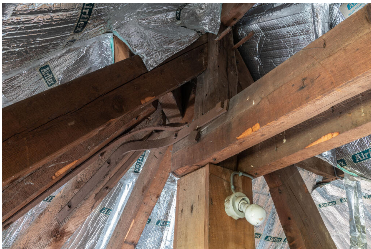
Détail de la charpente du belvédère.
