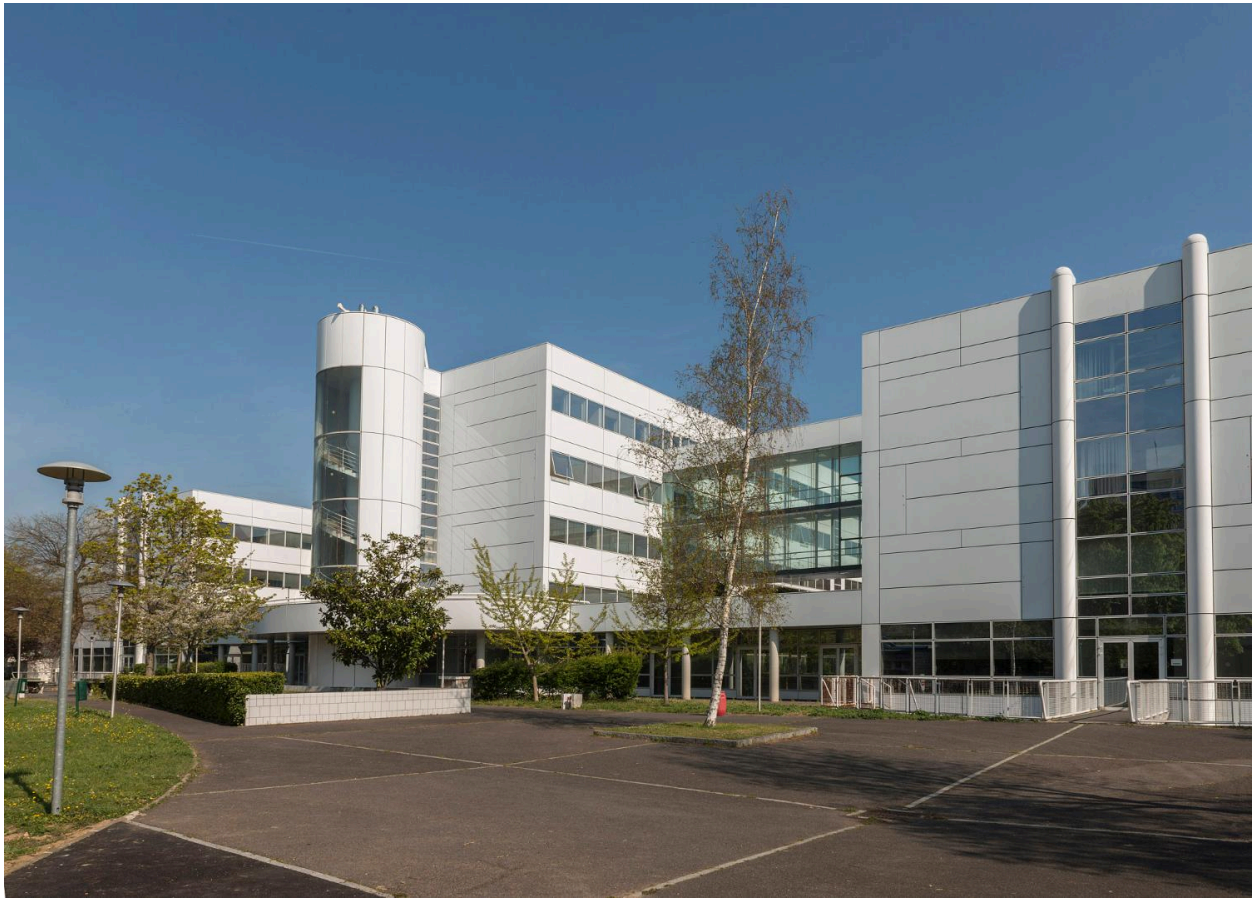
La façade postérieure du lycée, sur cour.
