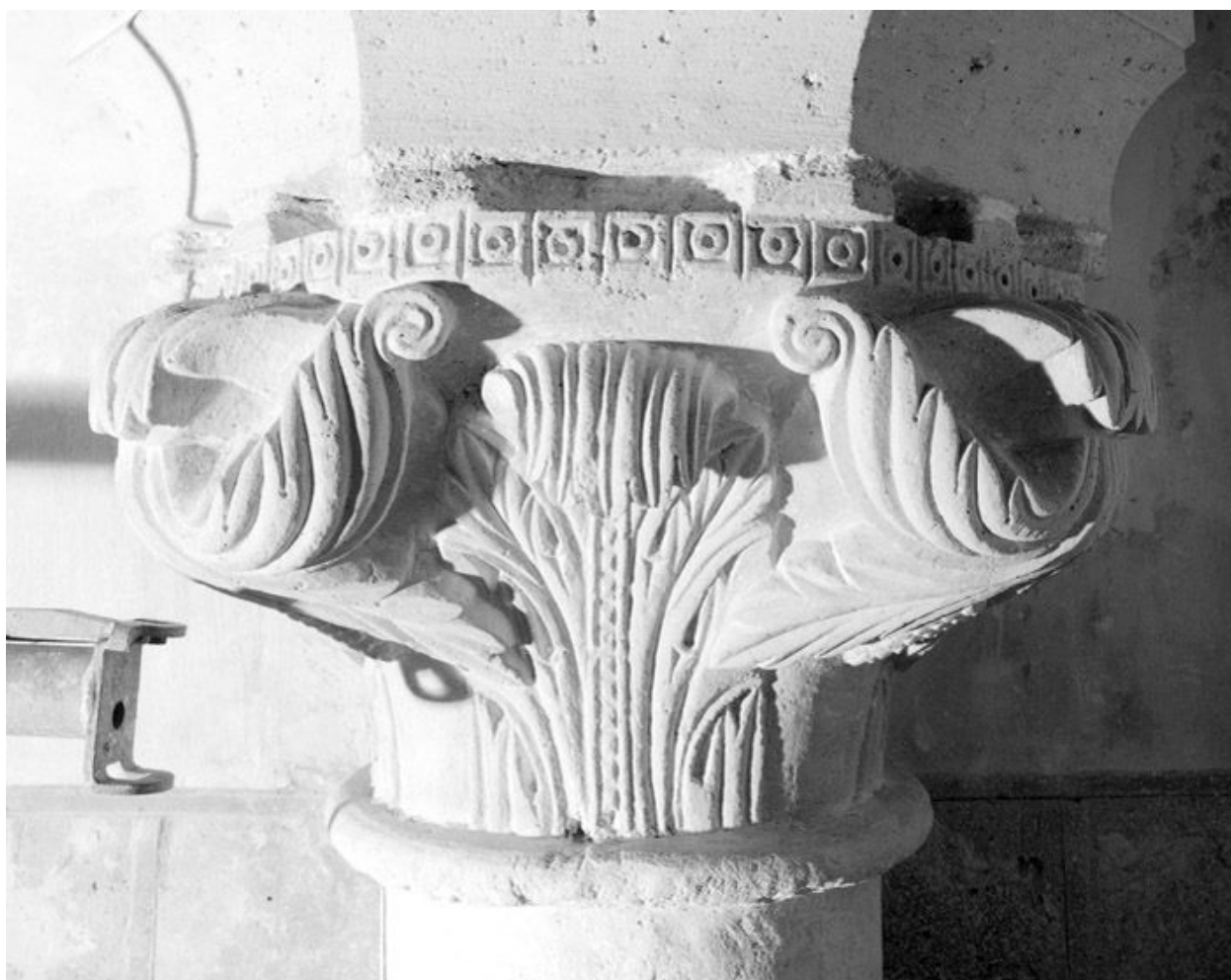
Le même chapiteau, vu depuis un échafaudage en 2005.
