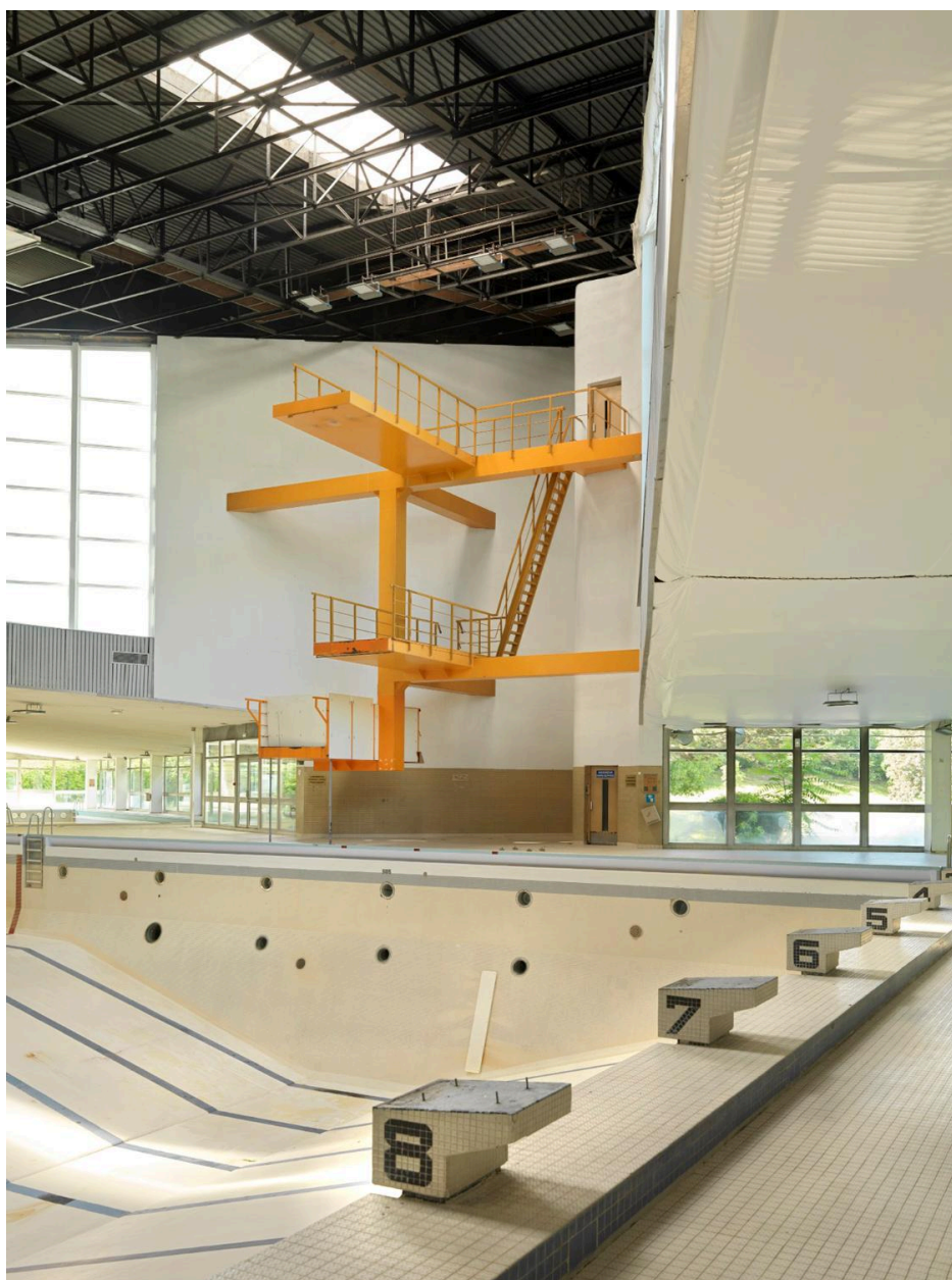
Sautoirs et plongeoirs de la piscine olympique de Colombes.
