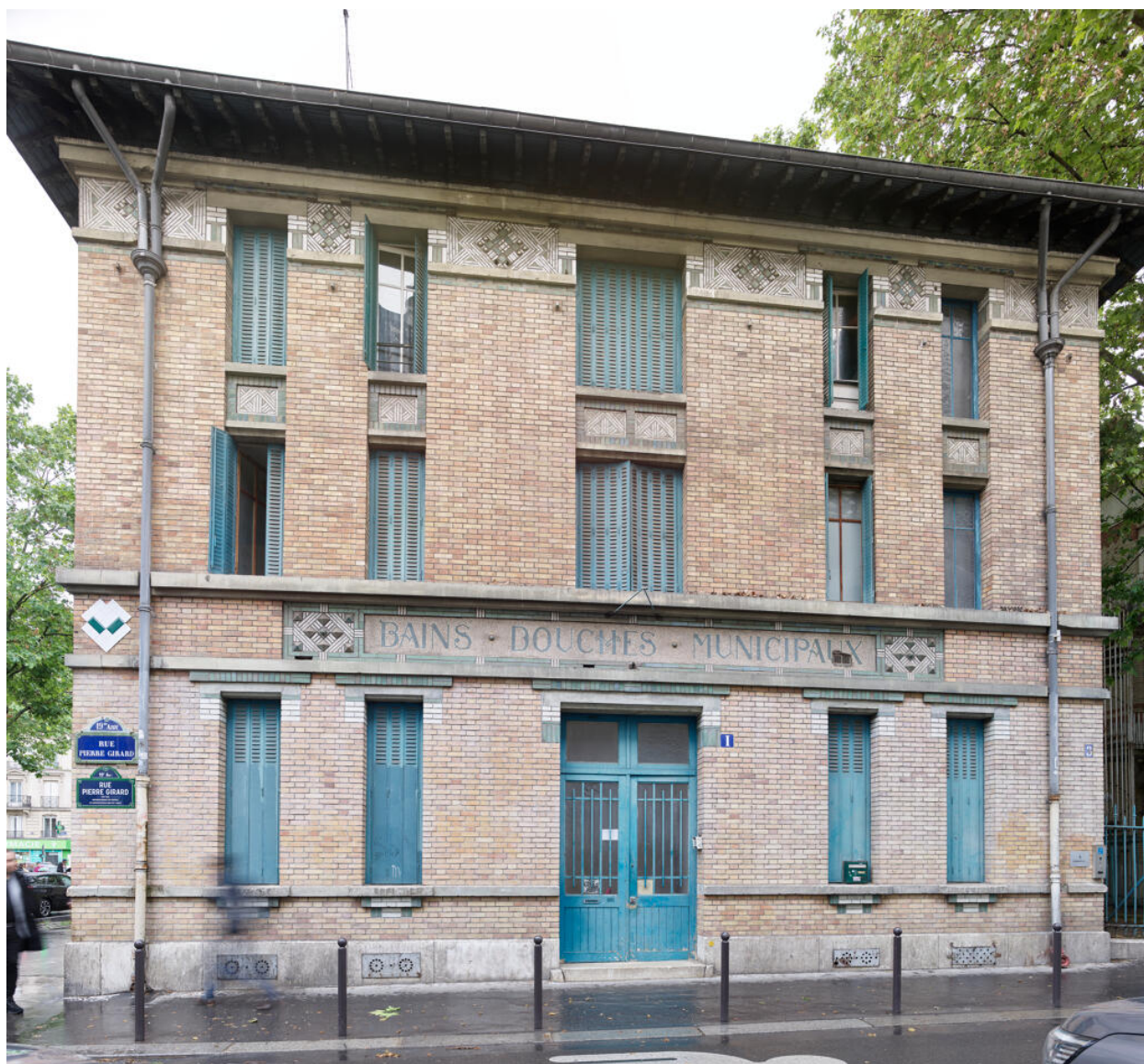
Le gymnase Jean Jaurès. Ancienne façade des bains-douches.
