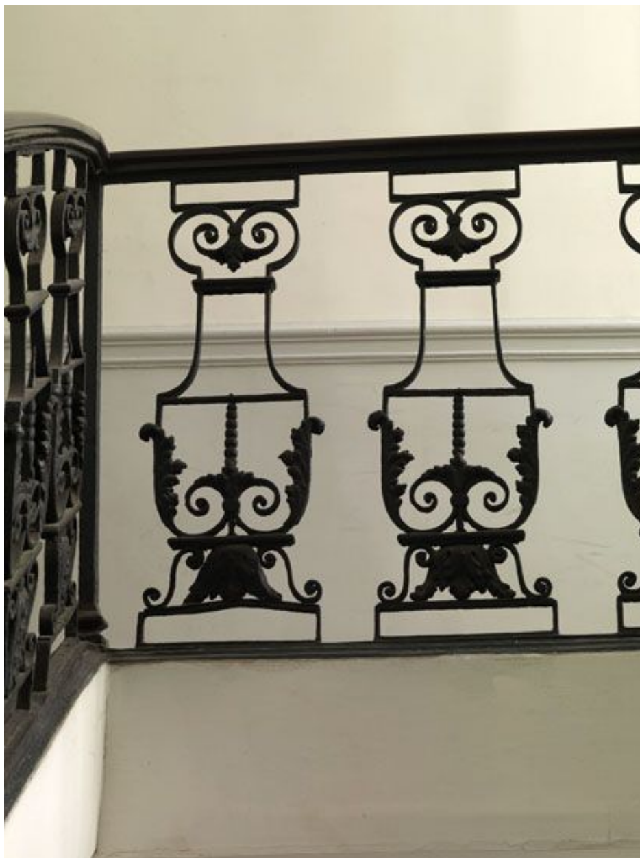
Balustres droits du dernier palier en partie refaits.
