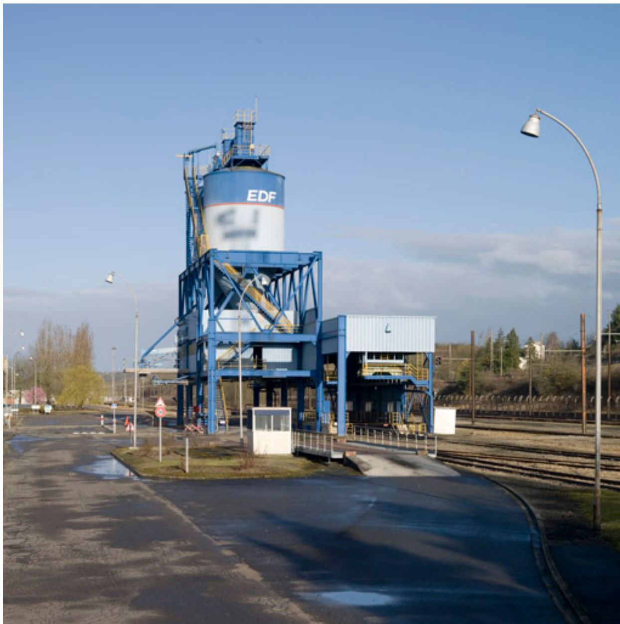
Réservoirs de fuel.
