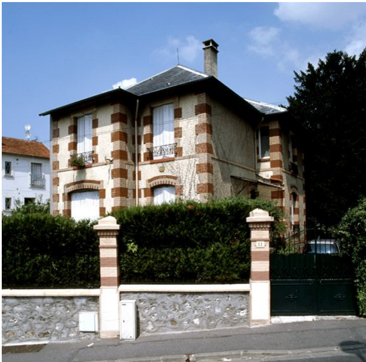
Maison, 11 rue Monument. Vue d'ensemble depuis la rue de la maison portant la date 1914.
