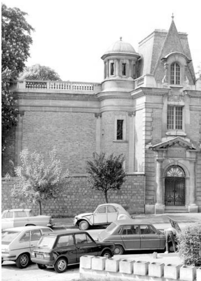
Vue d'ensemble de la bibliothèque depuis la rue. Photographie prise en 1986.
