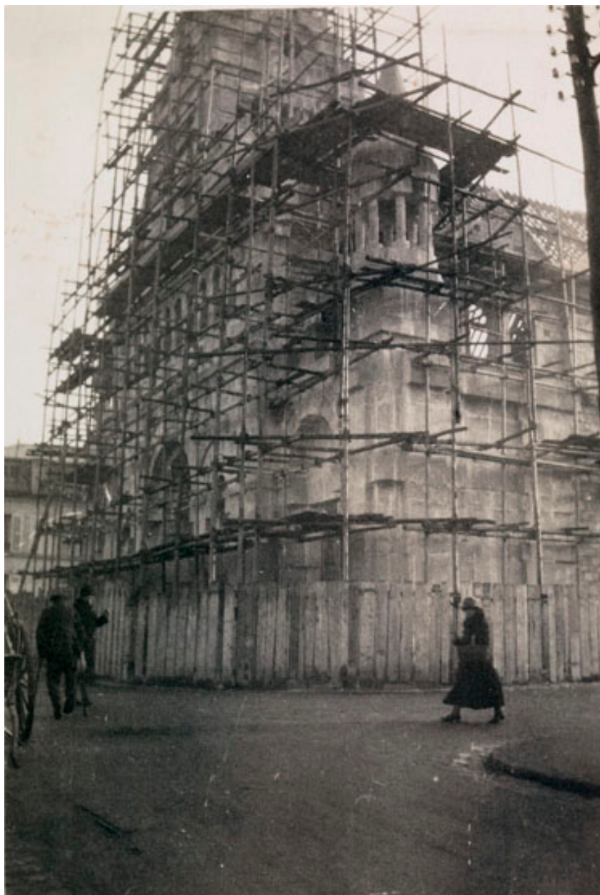
Vue de la construction de l'agrandissement en 1930 : façade. (AM Enghien-les-Bains, M48)
