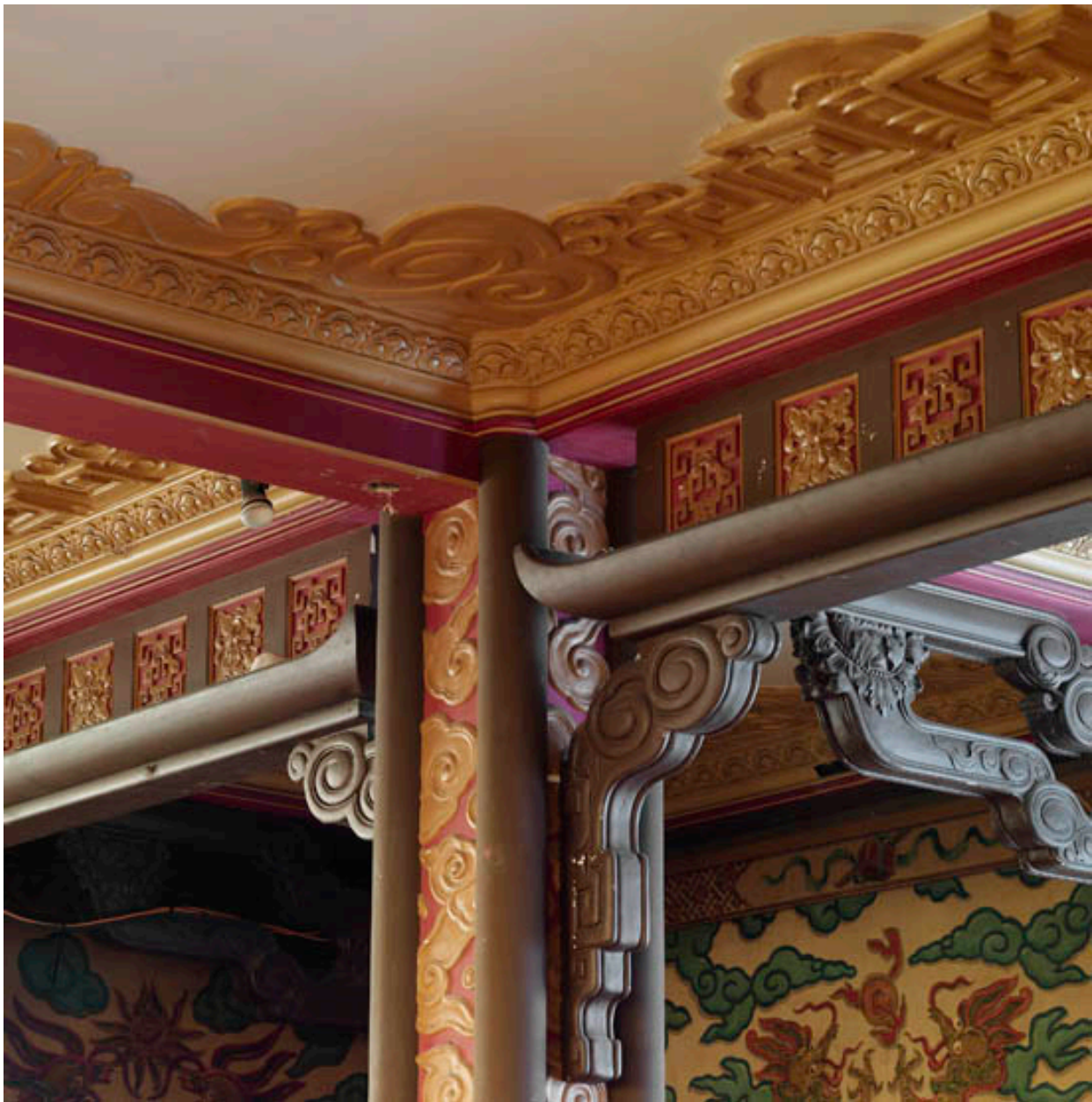
Grand salon : ornementation en staff peint des structures et du plafond.
