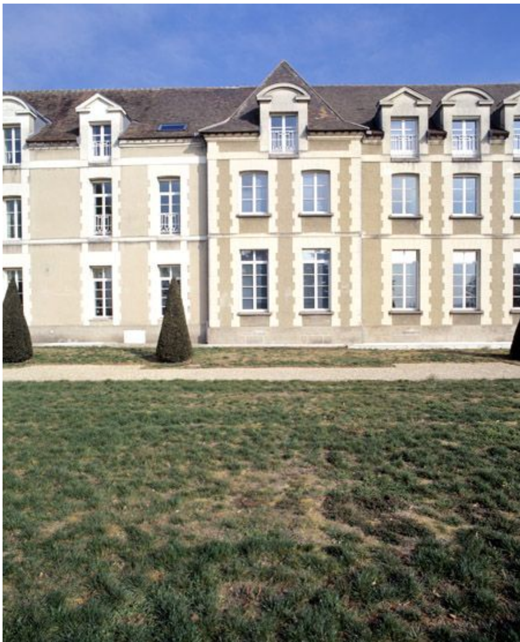
Détail de l'élévation sud : l'avant-corps central, à la jonction de la partie ancienne et de l'agrandissement apporté en 1938.
