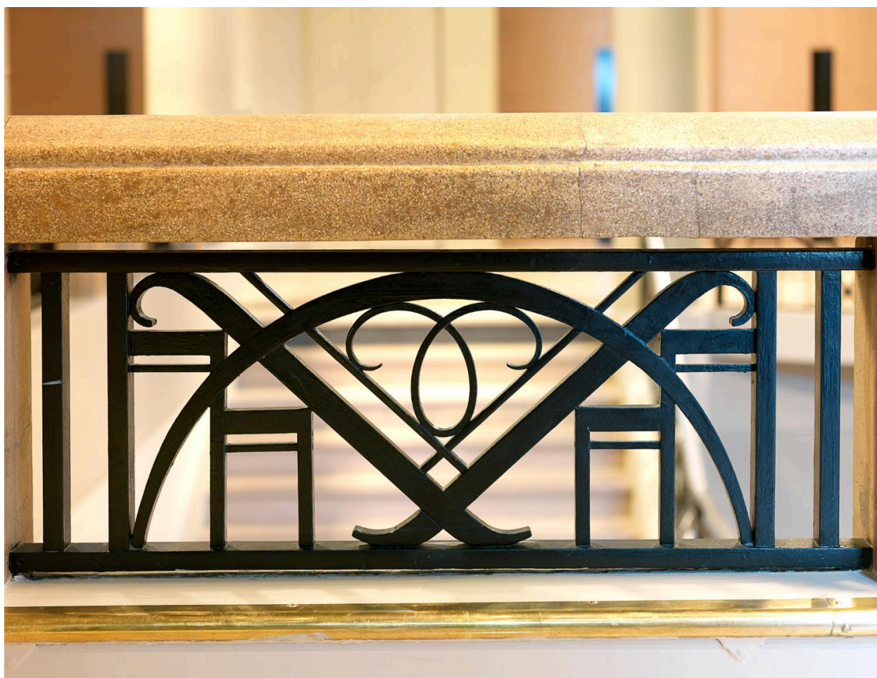
Escalier, détail de la rembarde de la galerie de l'escalier d'honneur
