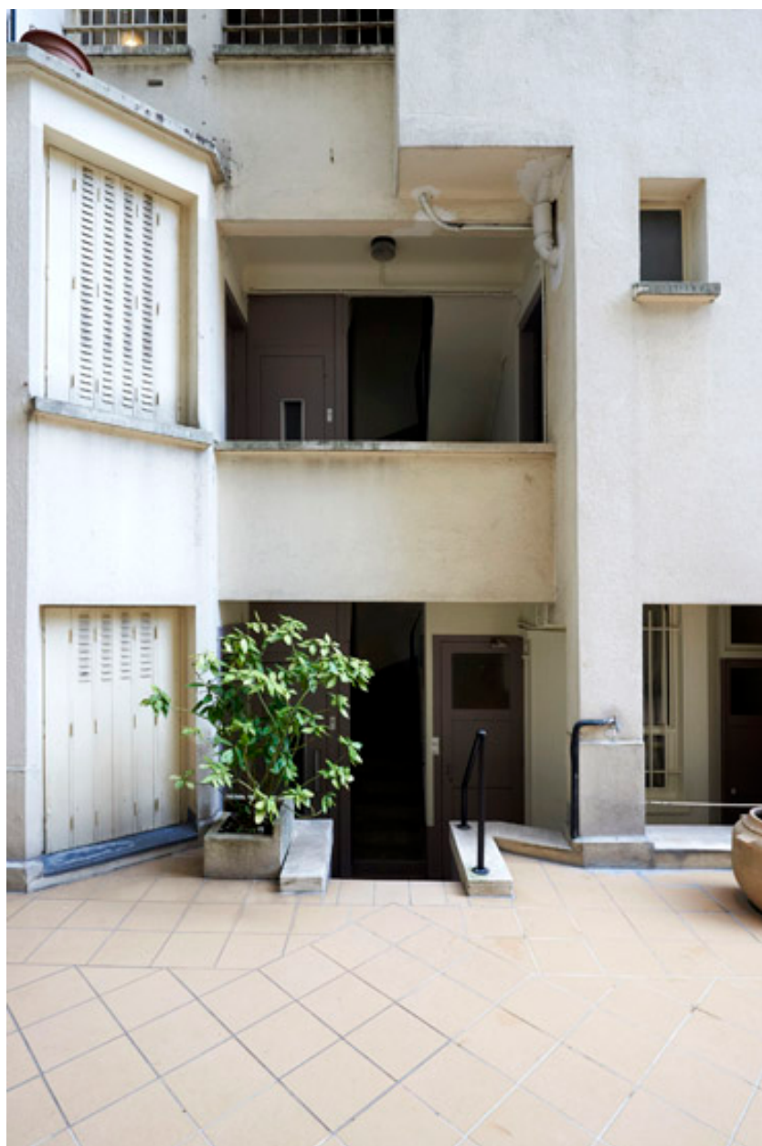
Vue de l'escalier et de l'ascenseur de service, côté gauche.
