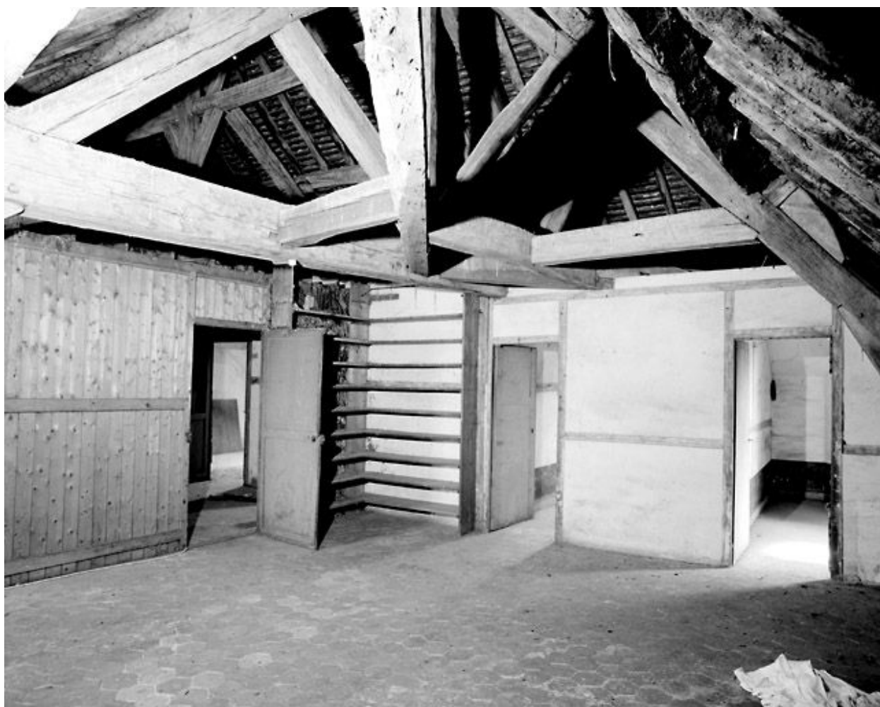
Vue des combles.
