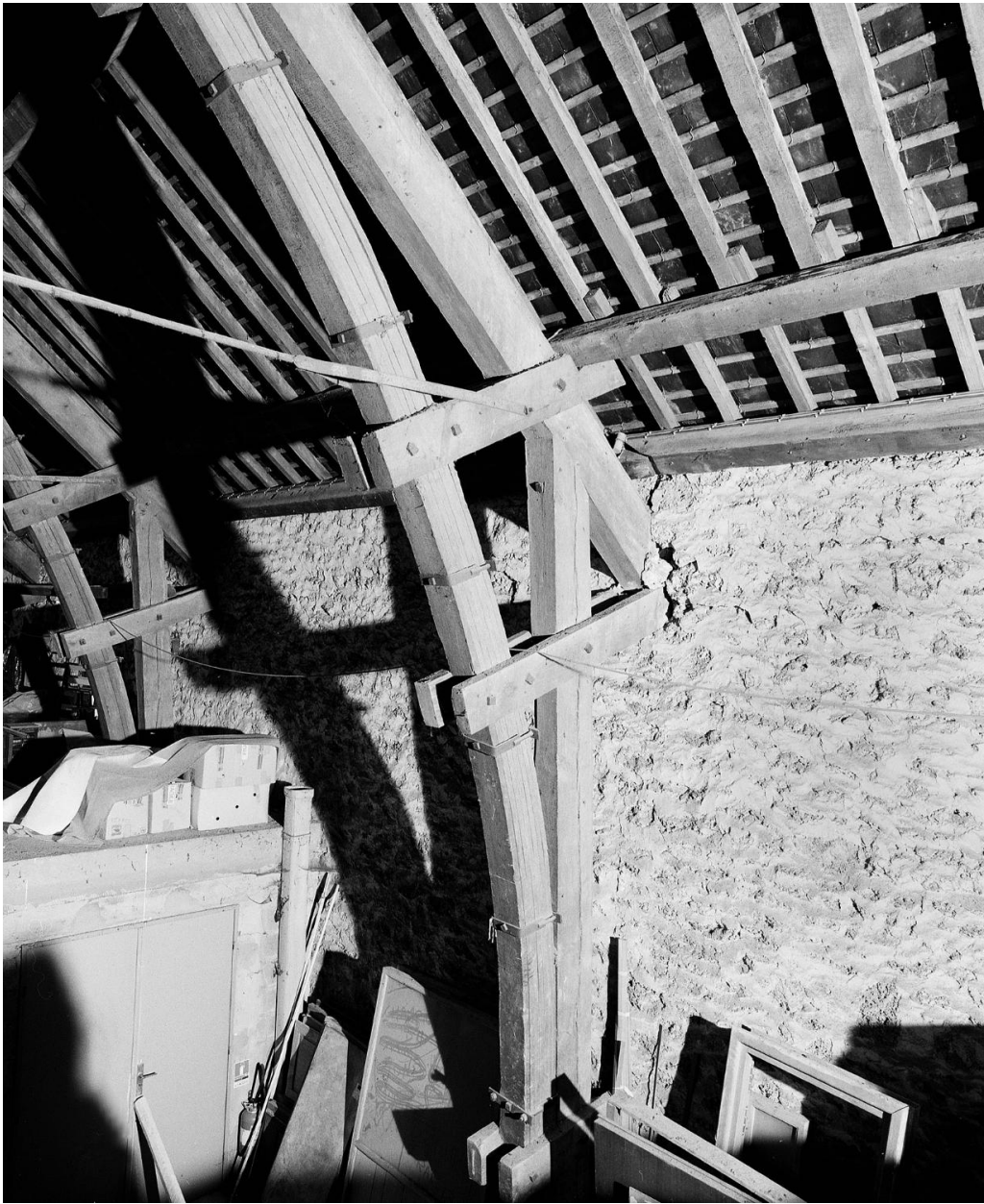
Charpente : détail de l'arbalétrier, des jambes de force et des blochets prenant appui sur le mur.
