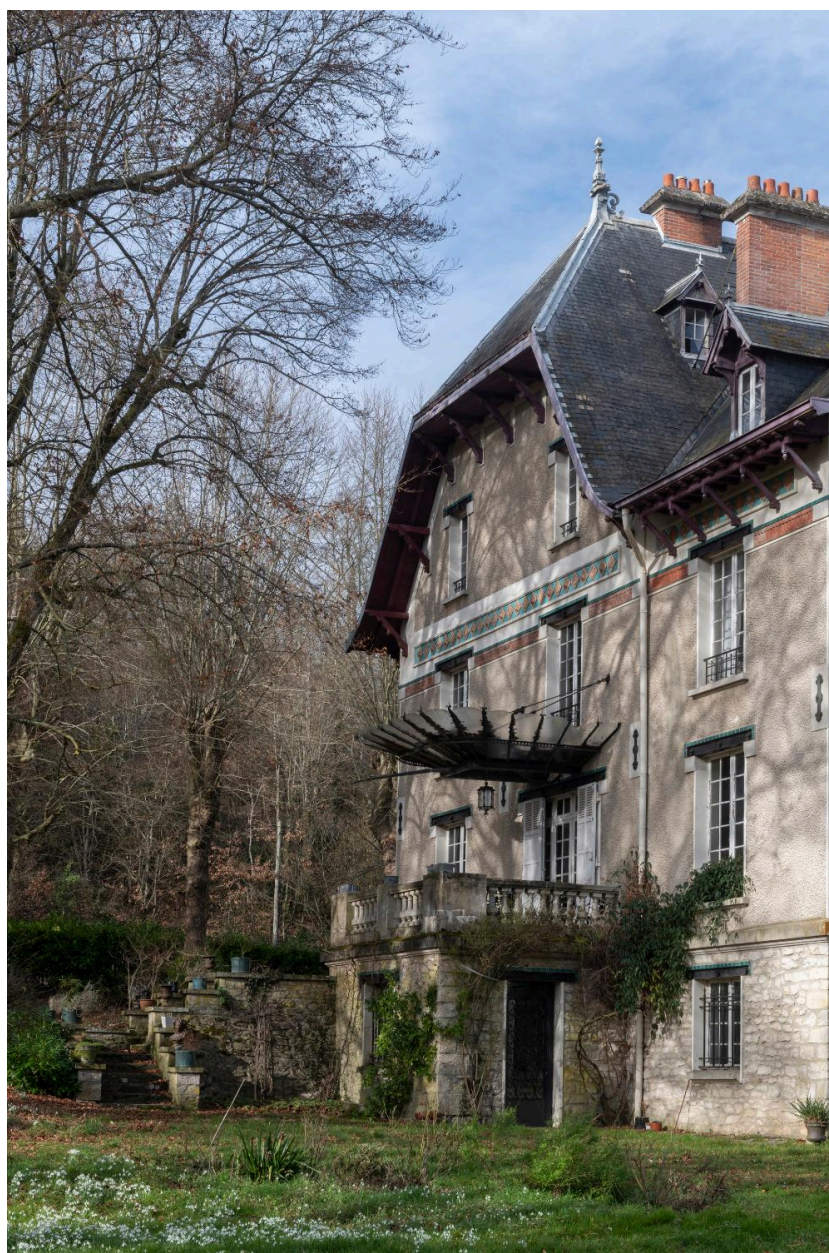
Façade sud-ouest, l'entrée et sa marquise inversée
