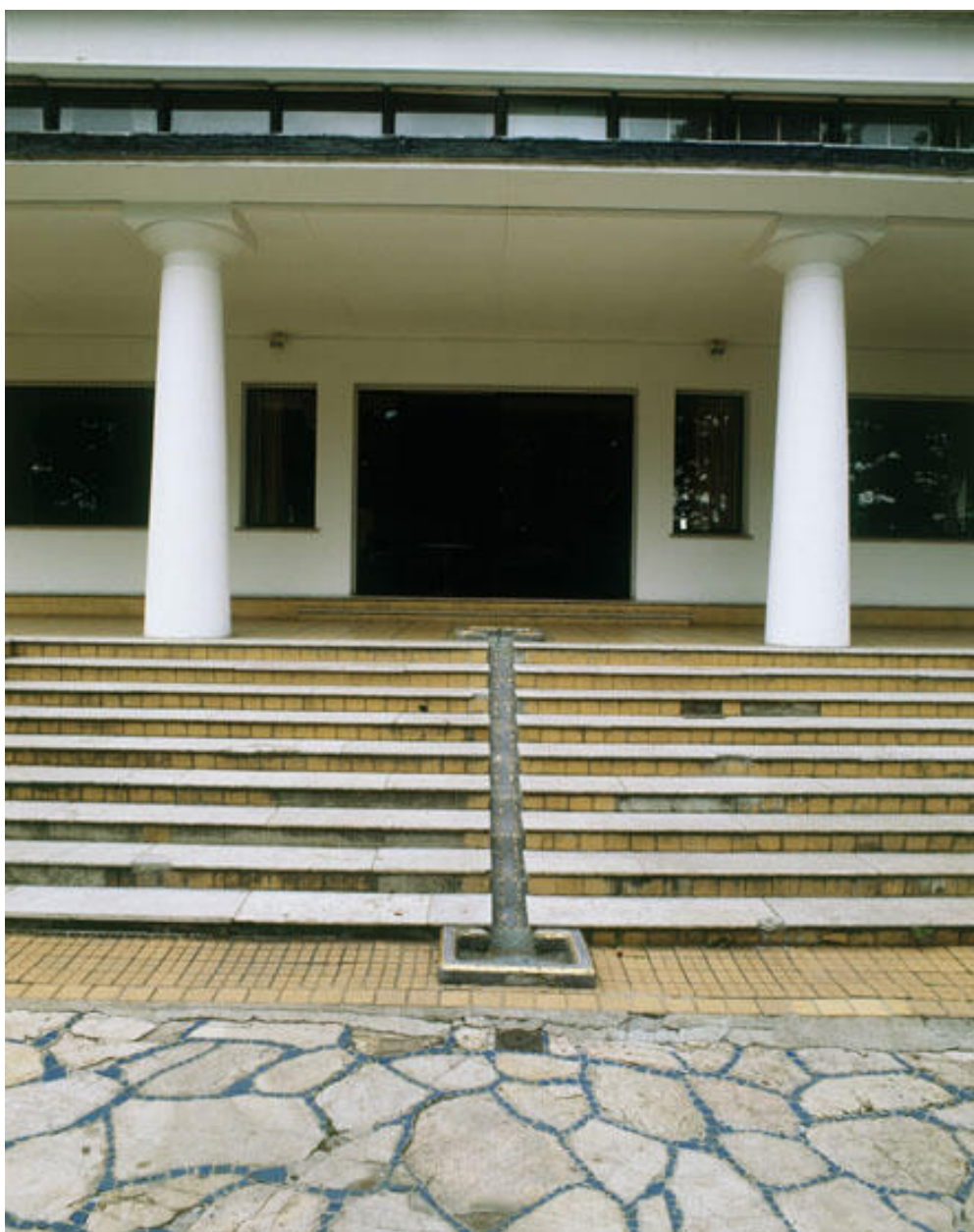
Détail de l'embranchement de la façade sud. Une petite "cascade" recouverte de mosaïque l'agrémente. Maison de maître dite Le Moulin Fidel
