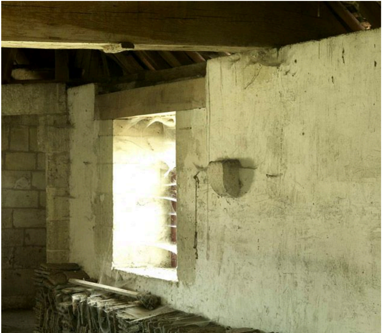
Corbeau dans le mur de l'étage de comble.
