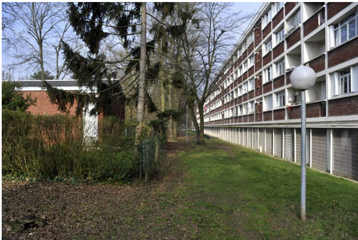
Verneuil-sur-Seine : le lotissement du Parc noir. Immeubles et maisons.
