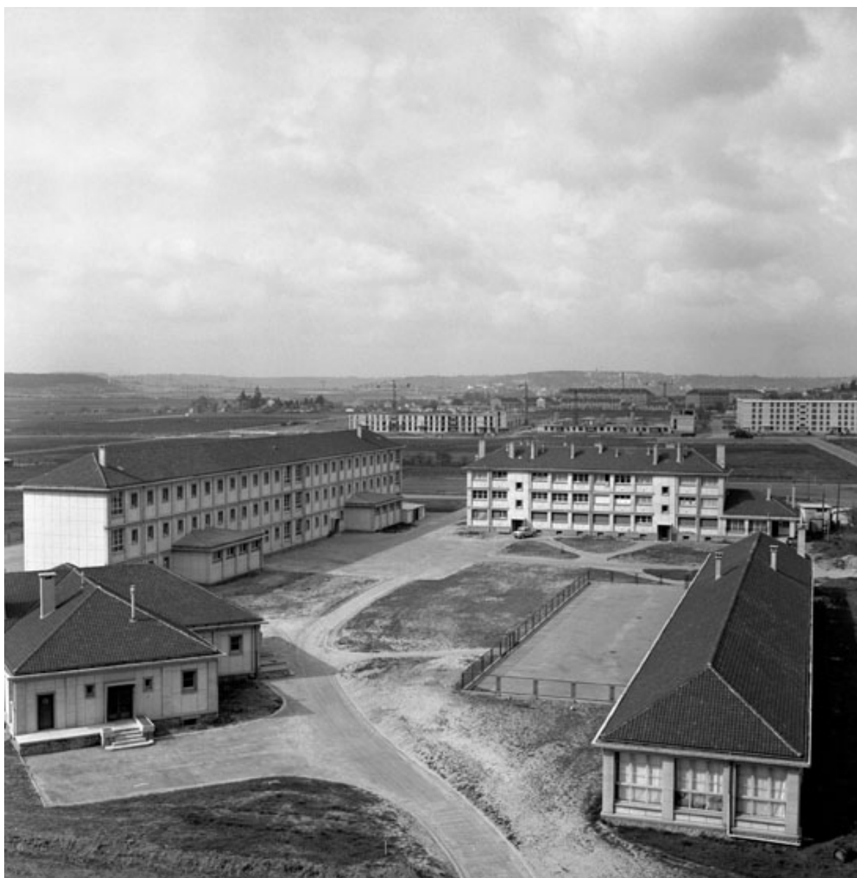
Vue générale. Photographie, 1960. (Ministère de l'Ecologie, MRU 35643)
