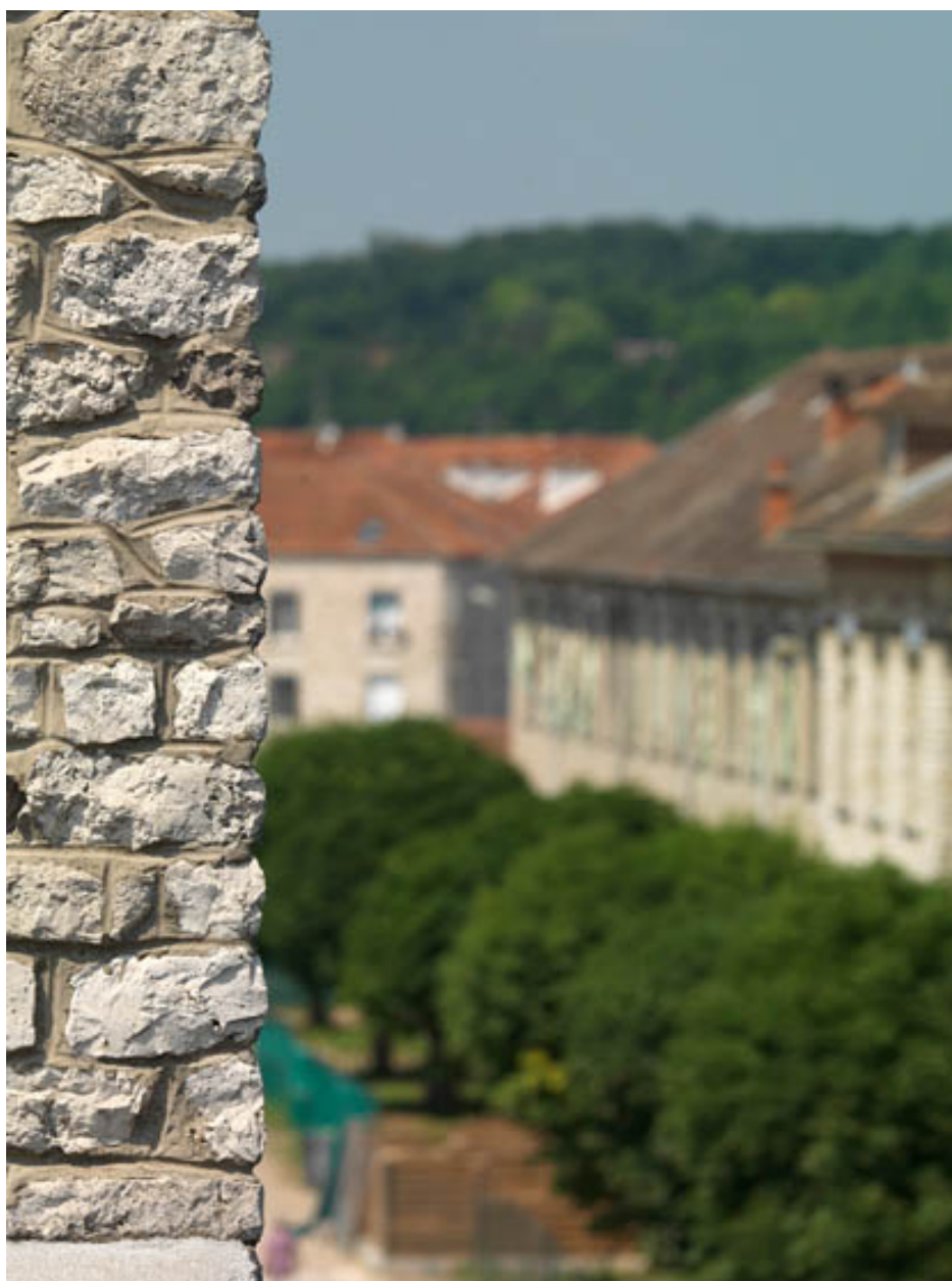
Détail de l'angle d'un mur en meulière blanche.
